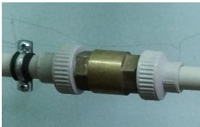
Рисунок 4.9 Обратный клапан
