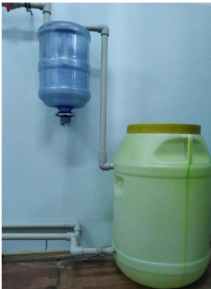
Рисунок 4.5 Общий вид бака и гравитационного сепаратора
